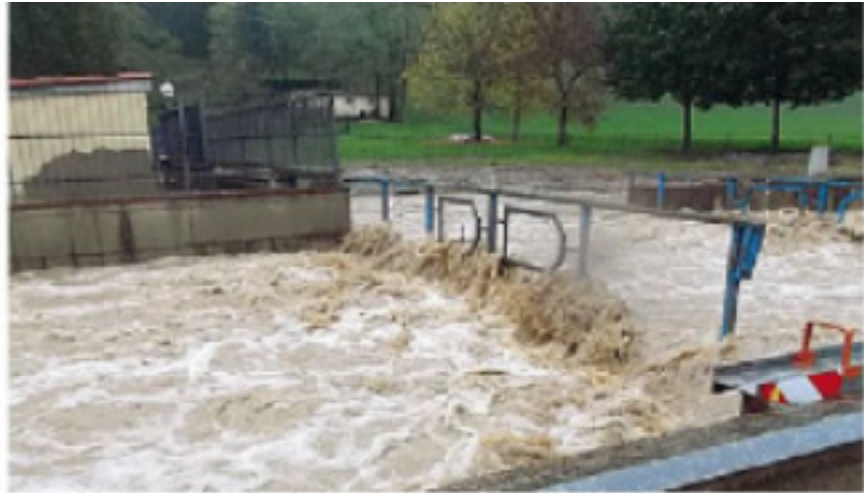
Sul Ponterosso il torrente in piena straripa dalla passerella: ora il via libera per abbatterla
